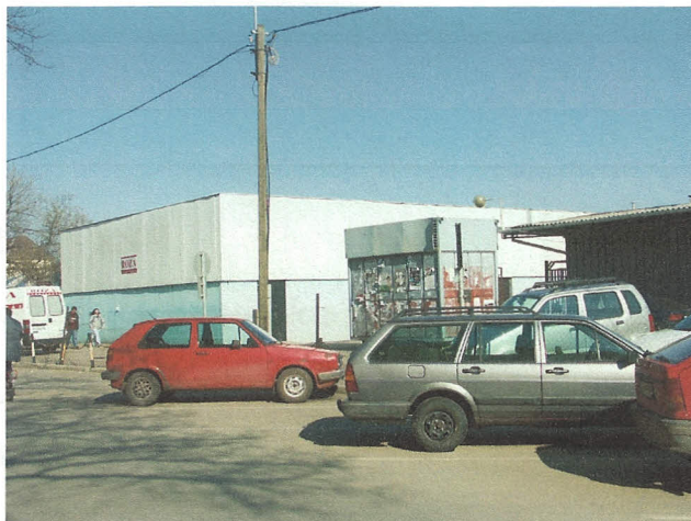
„P” Pavilon északnyugati homlokzata
