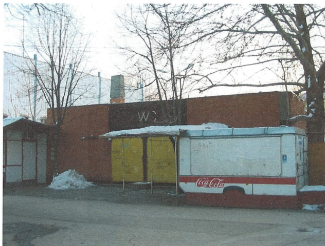
WC épület északkeleti, homlokzata, bejárat
