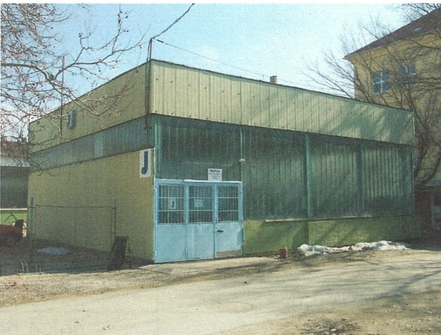
Északkeleti – északnyugati homlokzat
