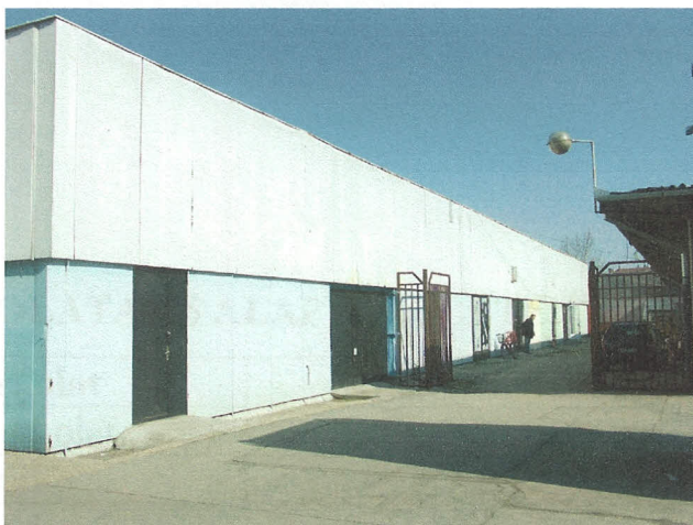
Délnyugati, hátsó homlokzat
