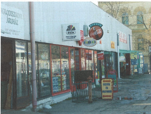
Északkeleti, piac felőli homlokzat részlet
